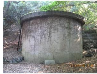
冷却用海水タンク
