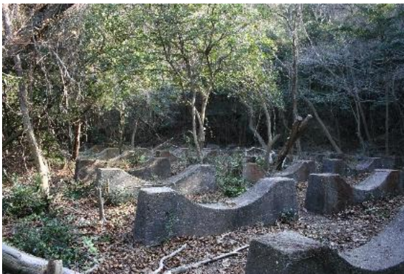
毒ガス貯蔵庫跡
